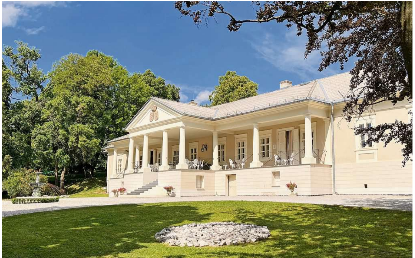
Erstrahlt nach der Renovation in neuem Glanz: Das Herrenhaus von Gut Péchy.
